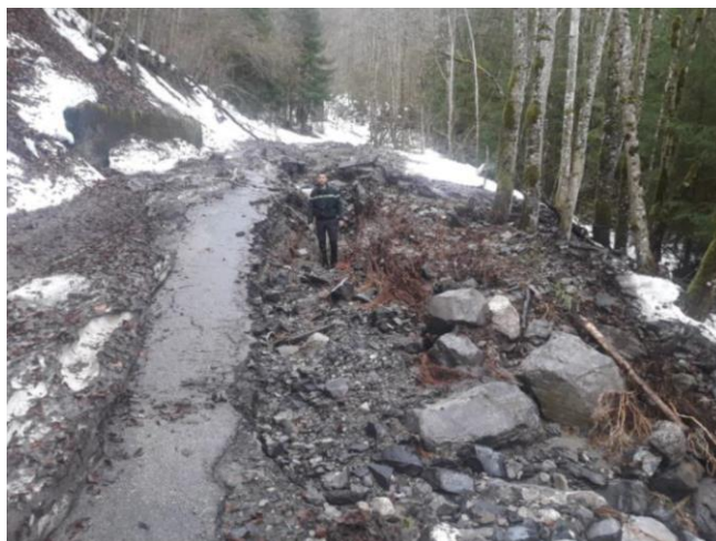
Figure 12 : dégâts de la crue de 2021 sur la route de Bellevaux sur le secteur du Pont de l'Étang (ONF, 2022).
