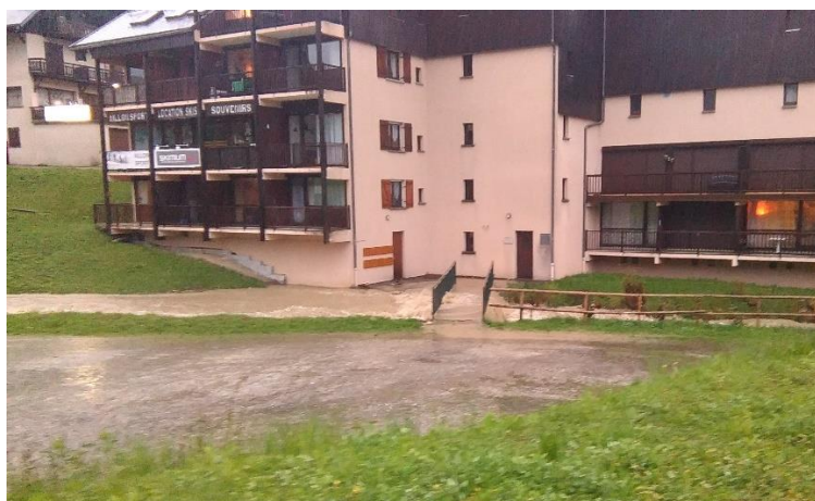
Figure 67 : débordements du ruisseau de la Fullie dans la copropriété Le Ste-Anne (SMIAC, 2015).
