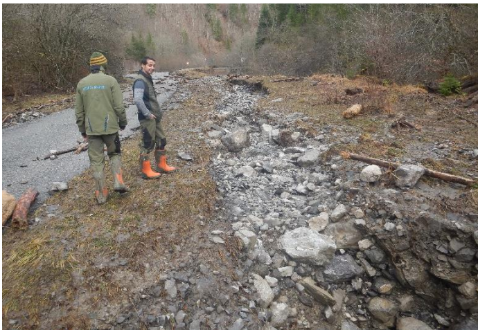
Figure 11 : dégâts de la crue de 2020 sur la route de Bellevaux sur le secteur du Pont de l'Etang (SMIAC, 2020).
