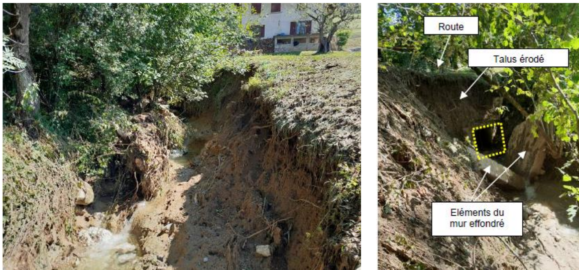
Figure 55 : A gauche : érosions latérales et incision du lit du ruisseau de Côte-Chaude à l'aval du hameau de Villard-Derrière. A droite : vue de l'aval du pont de Côte-Chaude (ONF-RTM, 2022).
