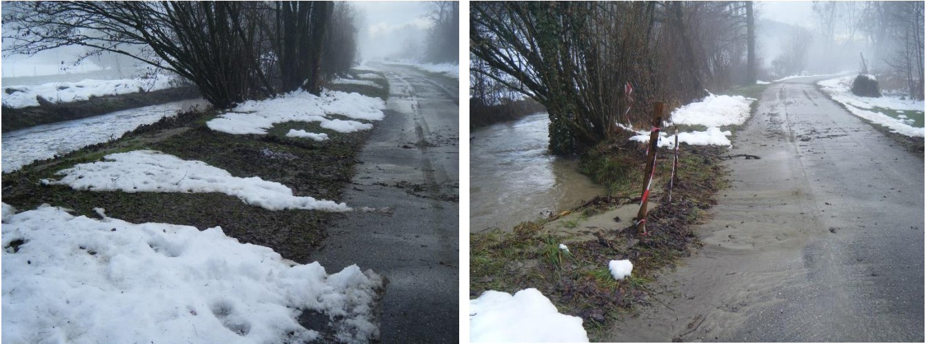
Figure 30 : débordements du Boiran aval sur la route communale. (SMIAC, 2012).
