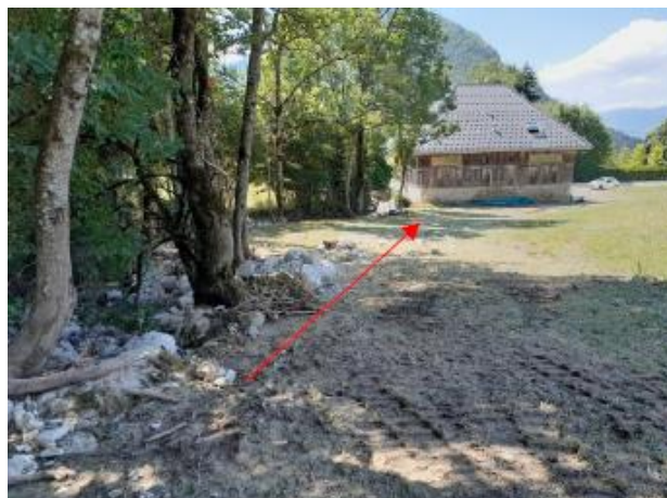
Figure 58 : débordement contre la façade amont du gîte en rive droite (ONF-RTM, 2022).
