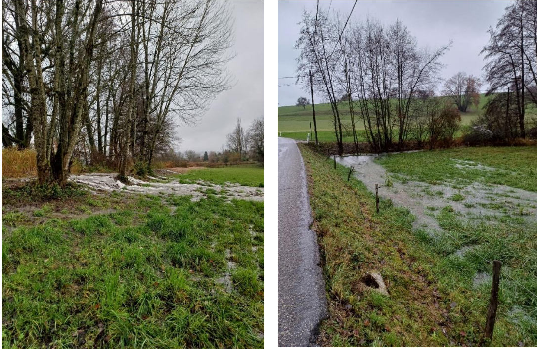
Figure 42 : débordements du bief de la Véïse (SMIAC, 2023).
